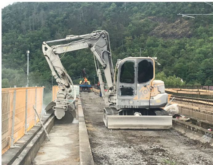
Obr. 8 Příčné řezání římsy
