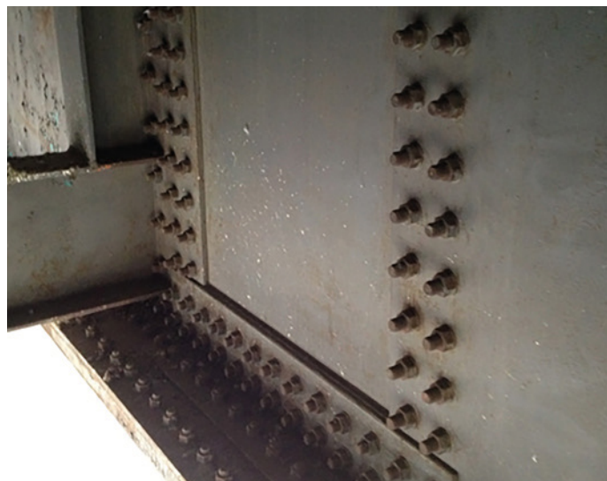
Obr. 11 Pohled na dolní část stěny po opravě – pohled zevnitř (foto: Tomáš Rotter)
