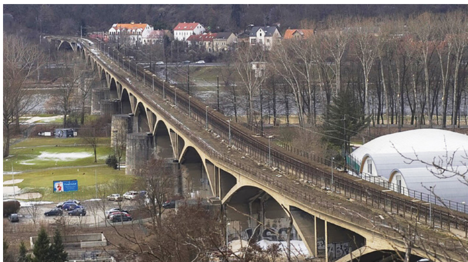
Obr. 2 Původní stav mostu
