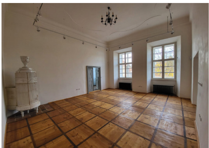
Obr. 14, 15 Obnova prostor východního křídla zámku
