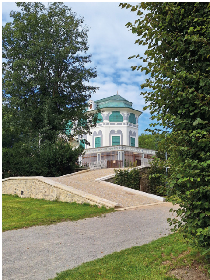
Obr. 20 Boční pohled z jihovýchodu na přístup do Bellarie po obnově, stav 2024
