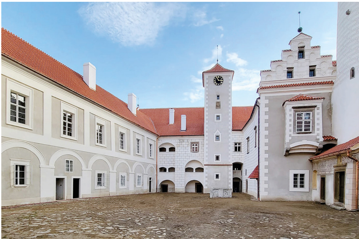
Obr. 1 Pohled na první nádvoří zámku Červená Řečice po obnově
