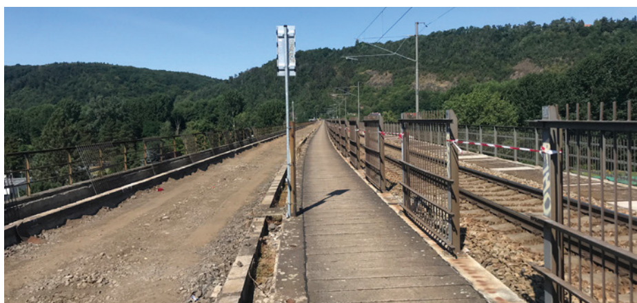
Obr. 3 Původní stav mostu
