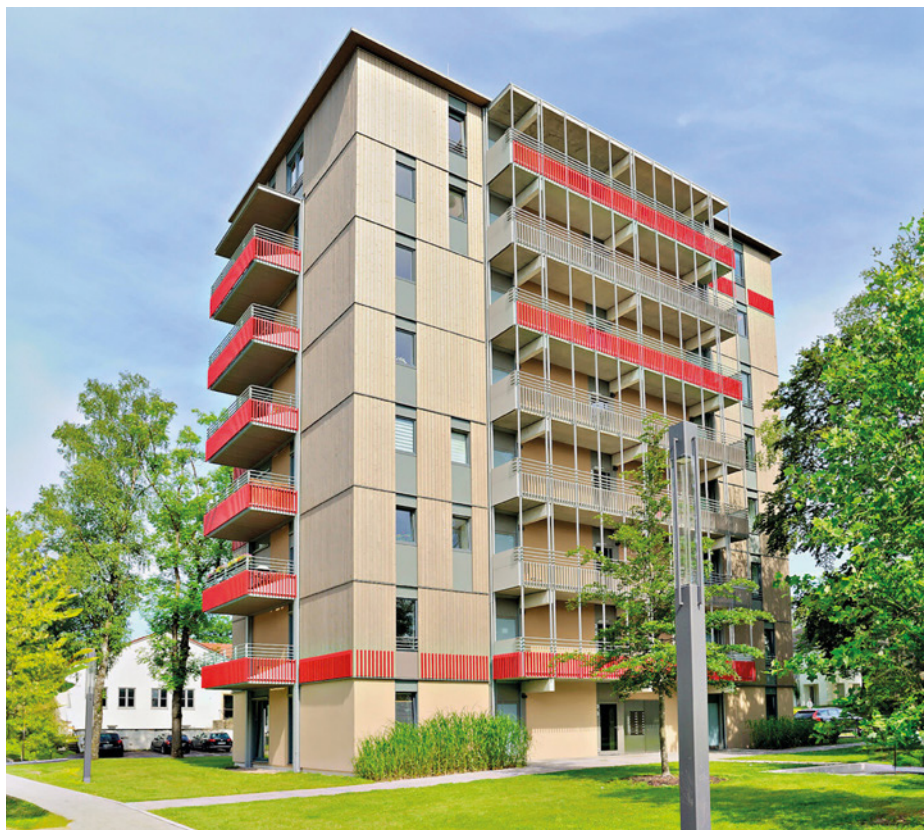
Obr. 6 Osmipodlažní dřevostavba H8
