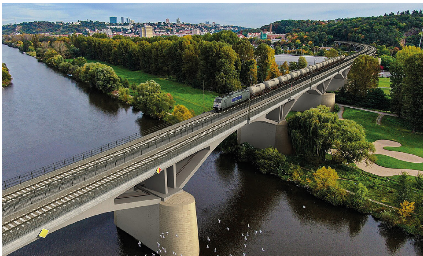
Obr. 1 Pohled na most po obnově
