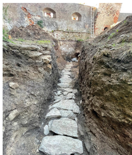
Obr. 19, 20 Oprava původní středověké kanalizace a její vyústění do vodního příkopu
