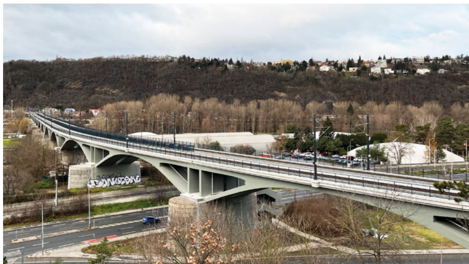
Obr. 18 Nový stav mostu po rekonstrukci
