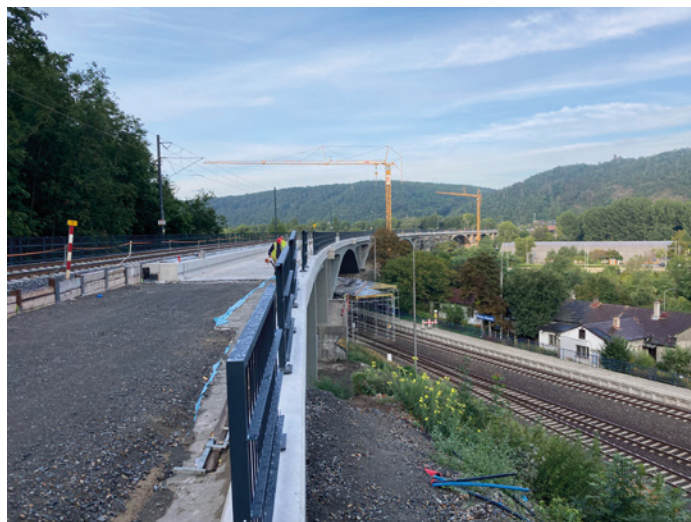
Obr. 14 Pohled na dva věžové jeřáby u pole NK2 a NK7
