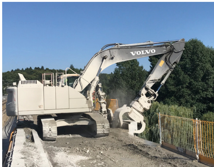
Obr. 9 Podélné řezání římsy
