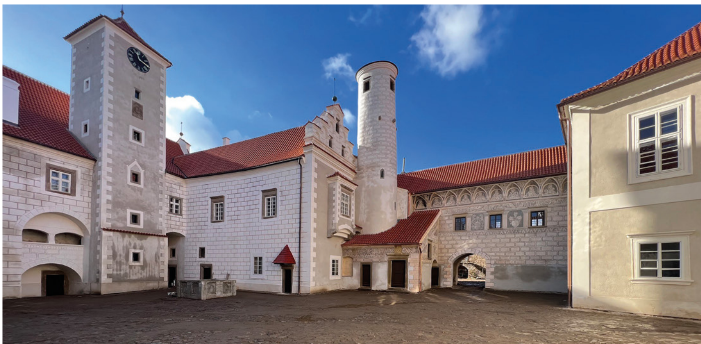
Obr. 8 Pohled na vnitřní fasády areálu zámku Červená Řečice
