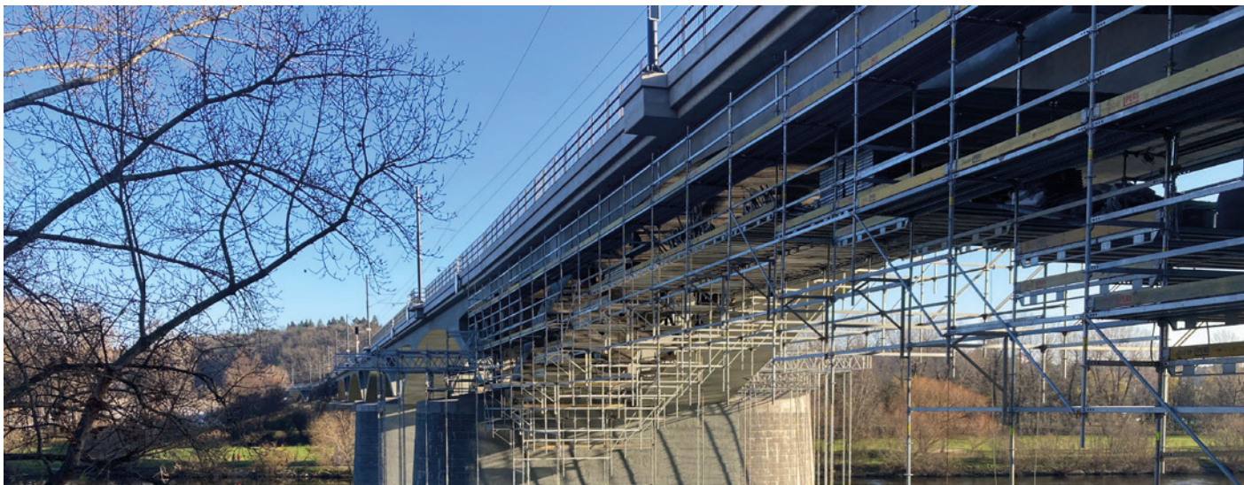
Obr. 17 Zavěšené lešení pro sanace stávajících částí
