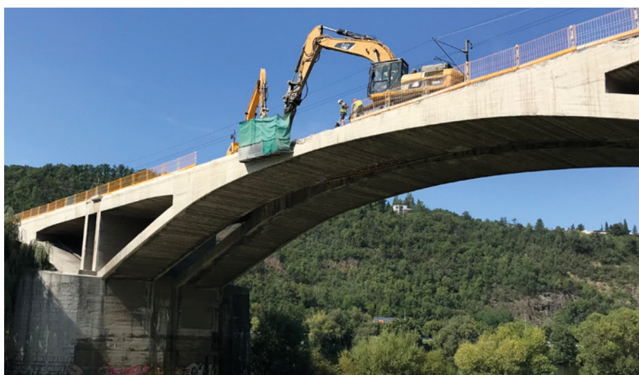
Obr. 12 Demolice zárodku vnější římsy
