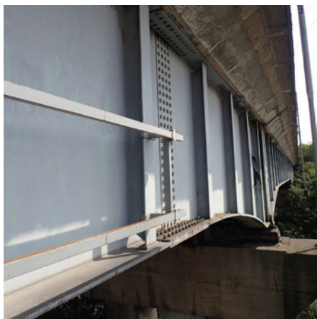
Obr. 8 Montážní styk hlavního nosníku [3]
