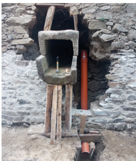
Obr. 19, 20 Oprava původní středověké kanalizace a její vyústění do vodního příkopu
