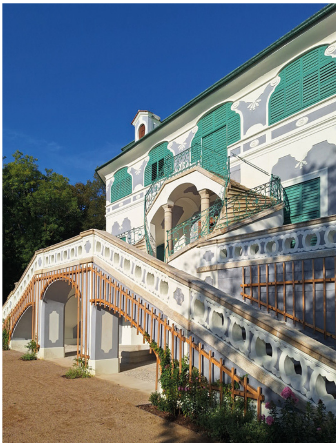
Obr. 19 Boční pohled z jihovýchodu na letohrádek Bellarie po obnově, stav 2024
