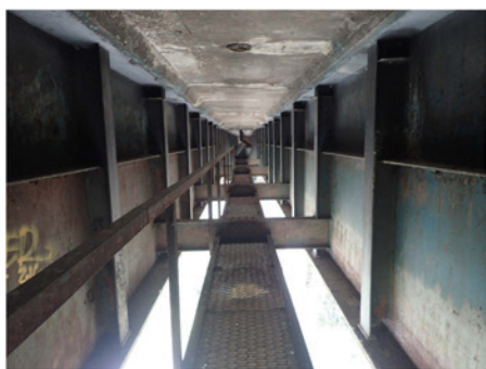
Obr. 6 Pohled do konstrukce. Pouze některé příčné výztuhy stěny jsou součástí příčného ztužení [3]
