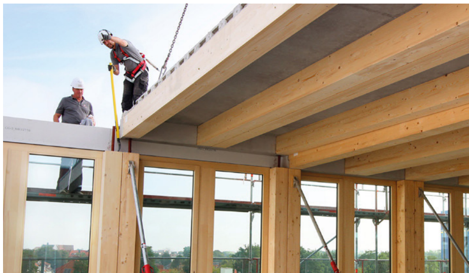
Obr. 2 Hybridní konstrukční systém LCT ONE
