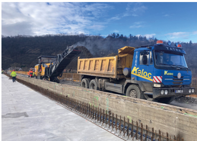
Obr. 10 Frézování výplňového betonu
