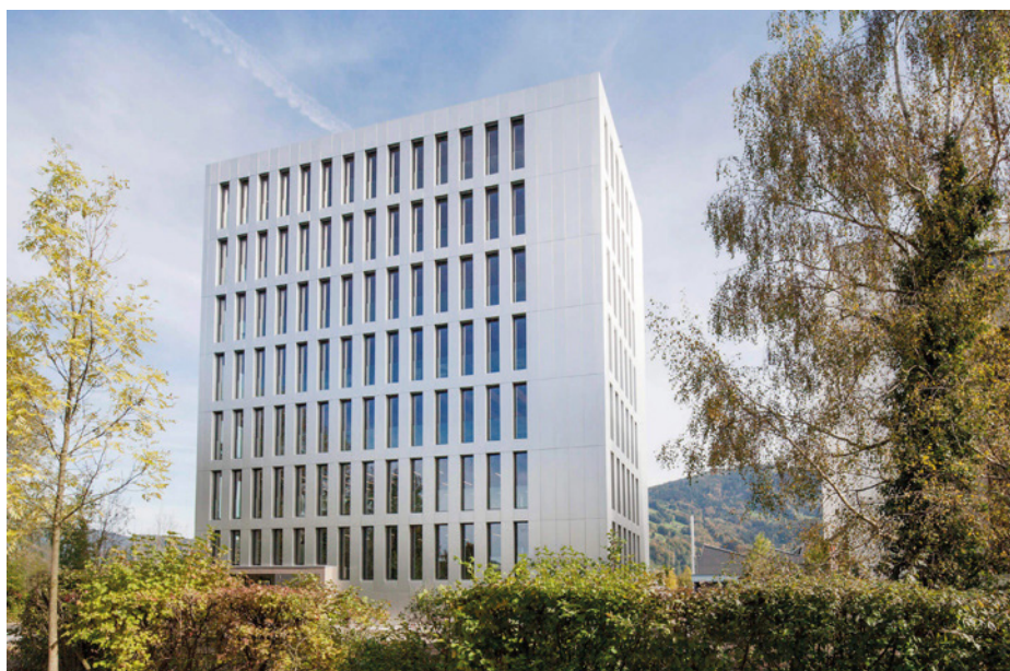
Obr. 3 Prototyp osmipodlažní dřevostavby LCT ONE
