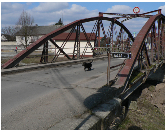
Obr. 8 Silniční most v Moravičanech z roku 1888 (bratři Kleinové), foto: Martin Vavrik, 2009, volné dílo
