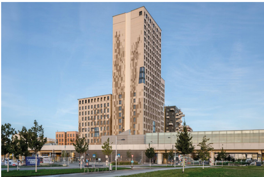
Obr. 4 Komplex vícepodlažních dřevostaveb HoHo Wien
