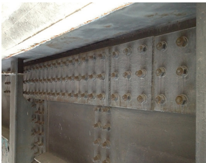
Obr. 10 Pohled na horní část stěny po opravě – pohled zevnitř (foto: Tomáš Rotter)
