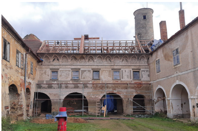
Obr. 10, 11 Obnova krovu střešní konstrukce a restaurované sgrafitové omítky.
