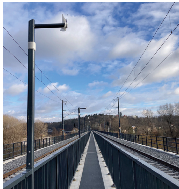
Obr. 16 Pohled na nový stav mostní konstrukce
