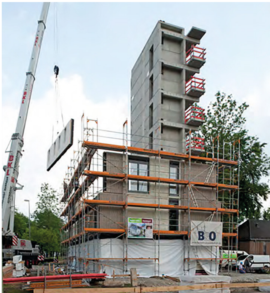
Obr. 7 Výstavba osmipodlažní dřevostavby H8
