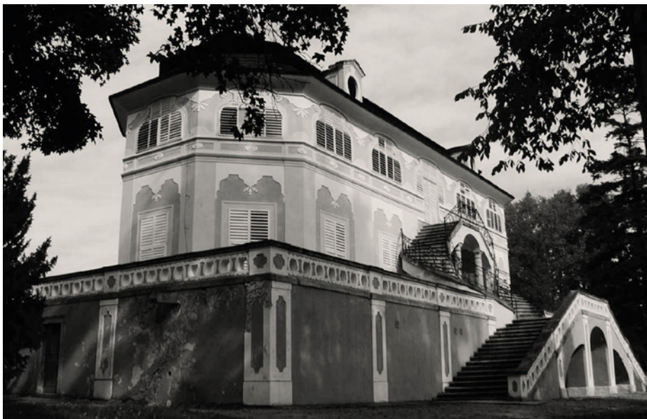
Obr. 4 Pohled na stavbu Bellarie z jihozápadu před obnovou, stav 2011
