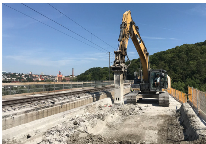
Obr. 11 Demolice říms
