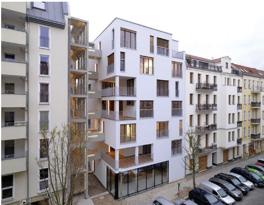
Obr. 5 Sedmipodlažní dřevostavba „e3“
