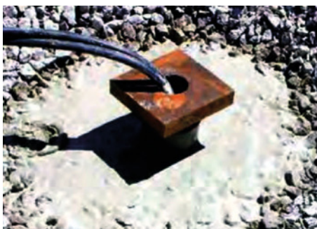
Obr. 11 Příklad vedení potrubí pro čerpání geotermální energie v ocelových mikropilotách
