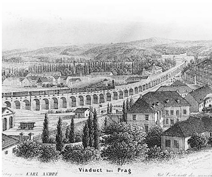
Obr. 9 Negrelliho (Karlínský) viadukt v 19. století (zdroj: Josef Rybička, Karel Brantl, Muzeum hlavního města Prahy, Věstník klubu za starou Prahu, 1854, lept, volné dílo)
