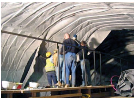
Obr. 1 Instalace energetické rohože v testovacím úseku raženého tunelu Lainzer ve Vídni
