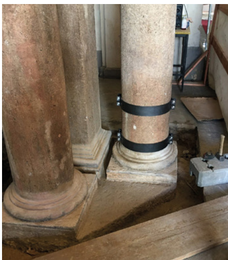
Obr. 14a, b Kamenické práce: a) u vybraných sloupů s menším rozsahem poškození stačilo kamenické doplnění dřívku a patky sloupu po vytažení zkorodovaného čepu a jeho nahrazení novým nerezovým, b) sloup po obnově
