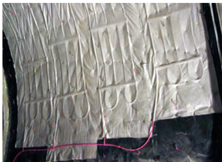
Obr. 1 Instalace energetické rohože v testovacím úseku raženého tunelu Lainzer ve Vídni
