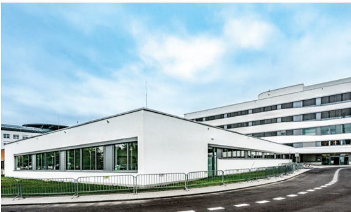
Obr. 4 Pohled na dvoupodlažní budovu centrálních operačních sálů (COS)
