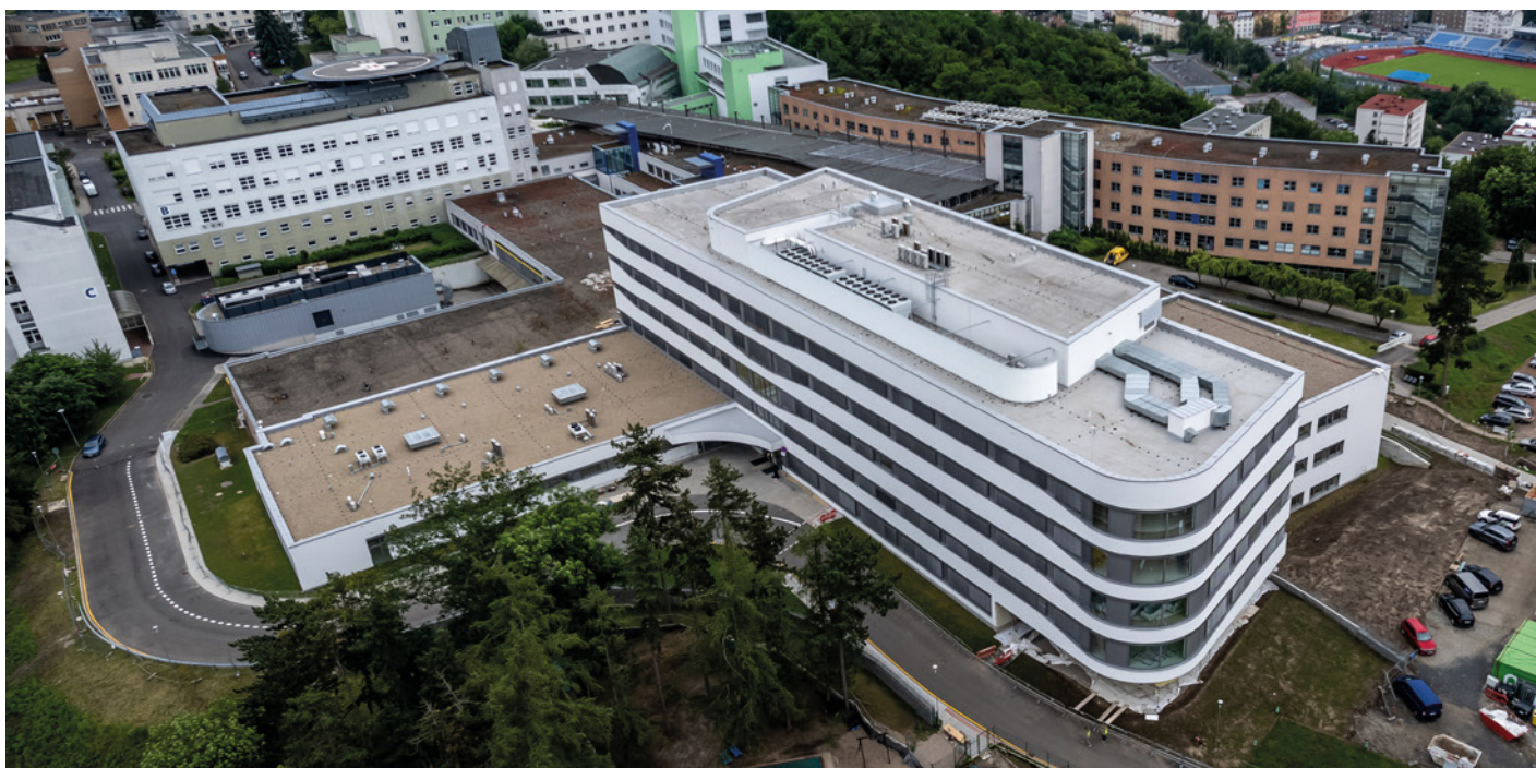
Obr. 8 Pohled na komplex nových zdravotnických budov v areálu Masarykovy nemocnice v Ústí nad Labem
