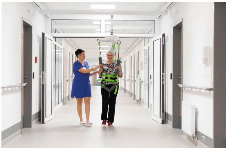
Obr. 10 Závěsný systém EriLens určený pro manipulaci s imobilními pacienty a nácvik chůze v rámci rehabilitačních cvičení
