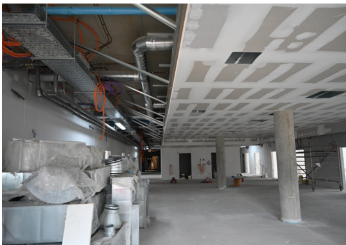
Obr. 11 Realizace komplexu a technického zařízení
