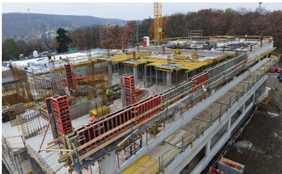
Obr. 10 Realizace komplexu nových zdravotnických budov
