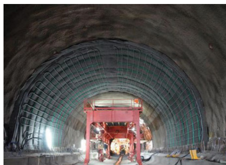
Obr. 2 Instalace energetické rohože ve zkušebním úseku tunelu Fasanenhof ve Stuttgartu
