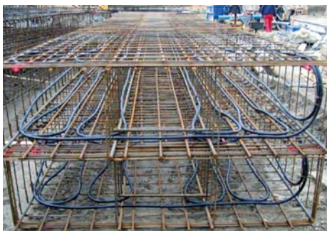
Obr. 8 Příklad vedení potrubí v armokoši podzemní stěny
