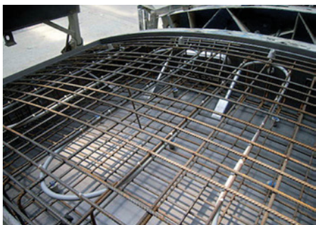
Obr. 7 Energetické kotvy s propojením hadic vedení média – stabilizace svahu na tunelu Lainzer
