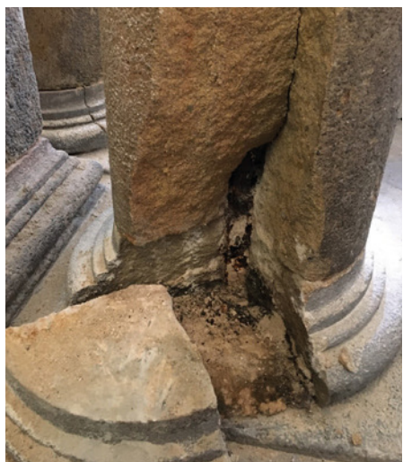
Obr. 14a, b Kamenické práce: a) u vybraných sloupů s menším rozsahem poškození stačilo kamenické doplnění dřívku a patky sloupu po vytažení zkorodovaného čepu a jeho nahrazení novým nerezovým, b) sloup po obnově
