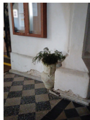
Obr. 14 Poděbrady, kostel Povýšení sv. Kříže, poruchy zdiva způsobené vlhkostí
