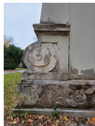
Obr. 4 Jihlava, kostel sv. Ducha, poruchy zdiva způsobené vlhkostí
