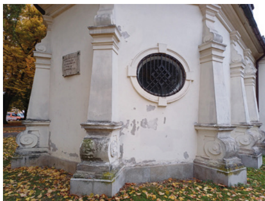
Obr. 4 Jihlava, kostel sv. Ducha, poruchy zdiva způsobené vlhkostí
