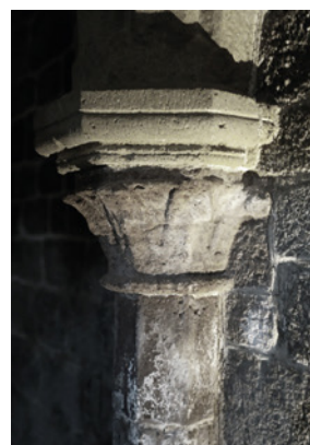
Obr. 7 Třebíč, bazilika sv. Prokopa – krypta, poruchy zdiva způsobené vlhkostí a salinitou
