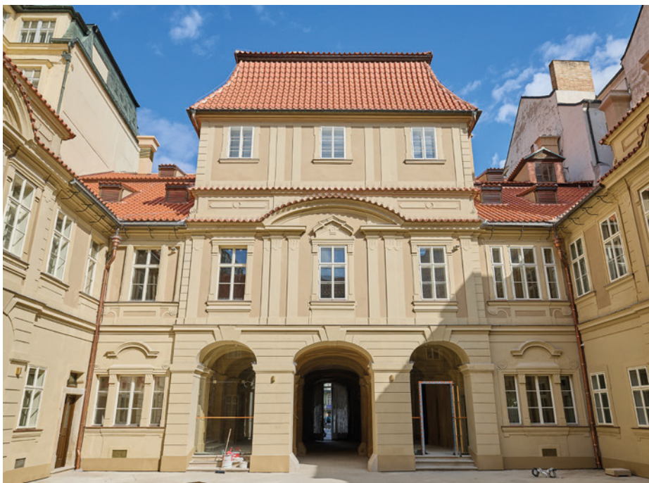
Obr. 7 Pohled na fasádu hlavního traktu z 1. nádvoří
