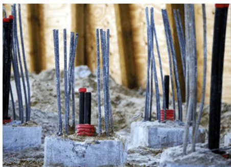
Obr. 9 Prefabrikované piloty s umístěním potrubí ve středu profilu
