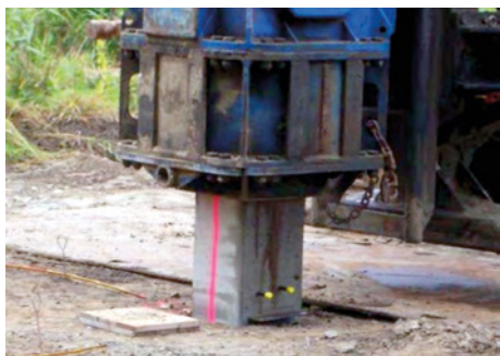
Obr. 9 Prefabrikované piloty s umístěním potrubí ve středu profilu
