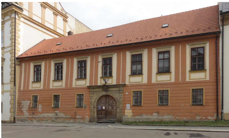
Obr. 1 Olomouc, palácová stavba
