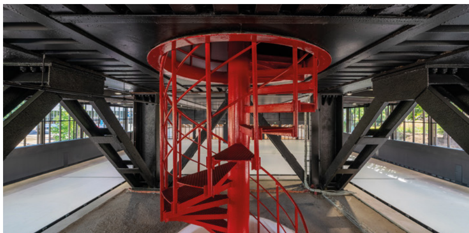
Obr. 4 Pohled na nosnou ocelovou konstrukci Křížkova pavilonu B a přístupové schodiště do veřejných prostor uvnitř supernosníku (foto: Jiří Šebek)
