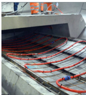
Obr. 13 Instalace potrubí v kanále odvádějícím horkou podzemní vodu – Brennerský bázový tunel
