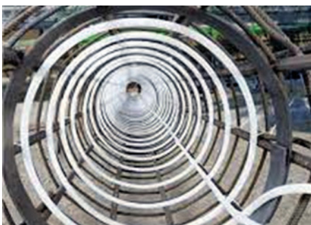
Obr. 10 Příklad vedení potrubí v energetických pilotách z monolitického betonu
