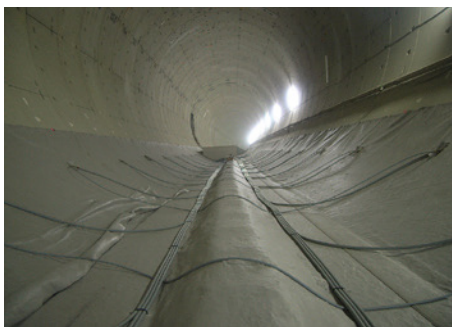
Obr. 7 Energetické kotvy s propojením hadic vedení média – stabilizace svahu na tunelu Lainzer
