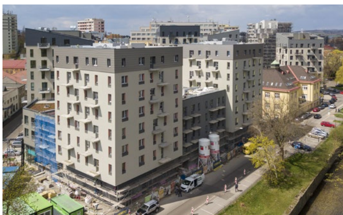
▲ Obr. 10 Pohled na III. etapu výstavby – Rezidence pro seniory RoSa
