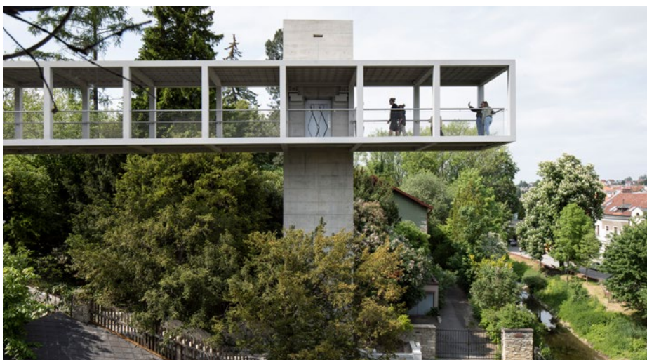
▲ Obr. 13 Pohled na lávku po dokončení
