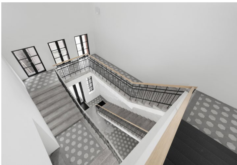
▲ Obr. 12 Pohled na původní třiramenné schodiště po rekonstrukci
