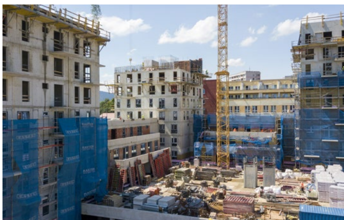
▲ Obr. 8 Pohled na II. etapu výstavby – Rezidence Oáza
