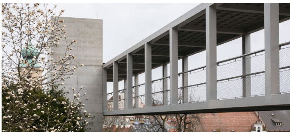
▲ Obr. 3 Detail konstrukce lávky
