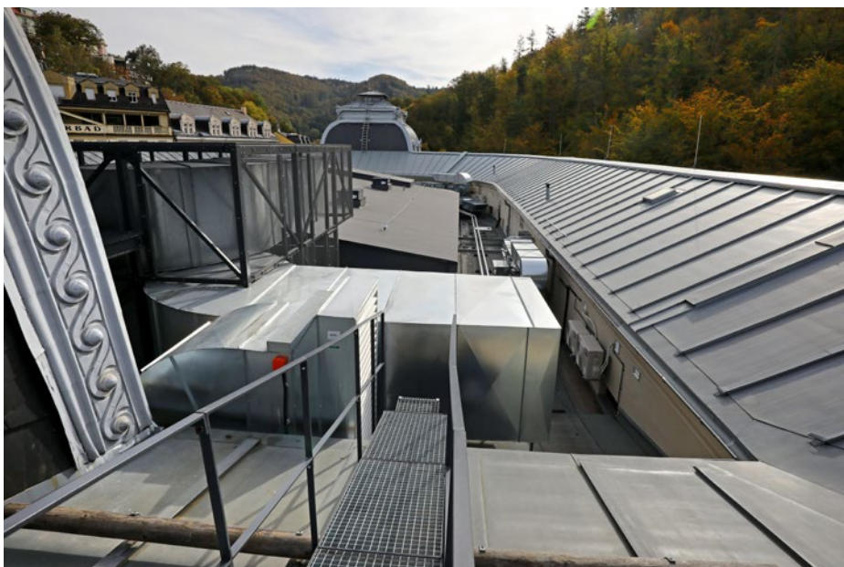
▲ Obr. 9 Nové zastřešení atria s prvky ZOKT a VZT jednotkou pro větrání atria (foto: Richard Dvořák)
