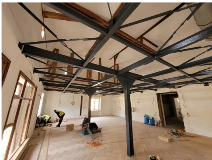
▲ Obr. 7 Vybourání stropu mezi 3.NP a krovem (zdroj: archiv autora)
