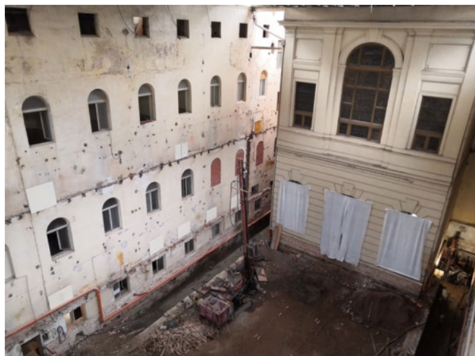
▲ Obr. 6 Atrium před rekonstrukcí, realizace podzemních konstrukcí (zdroj: archiv autora)
