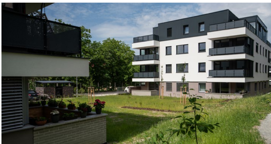
▲ Obr. 6 Stavba bytových domů Mírová v Dobrušce, stav po dokončení, květen 2023
