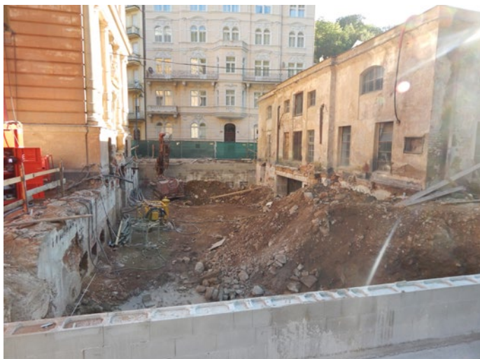
▲ Obr. 5 Vybourání podzemní části Rašelinového pavilonu, výkop pro servisní trakt (zdroj: archiv autora)
