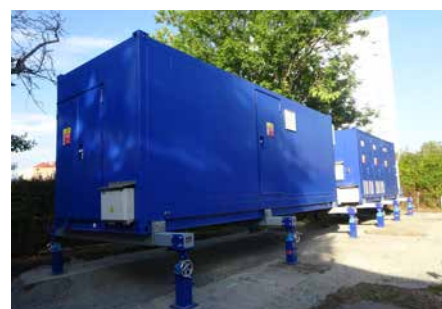
▲ Obr. 7 Sestava kontejnerů po umístění na staveništi
