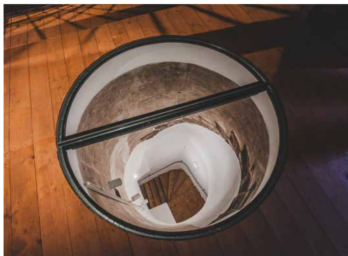
▲ Obr. 18 Původní schodišťová věž skrytá pod podlahou unikátního goticko-renesančního krovu paláce
