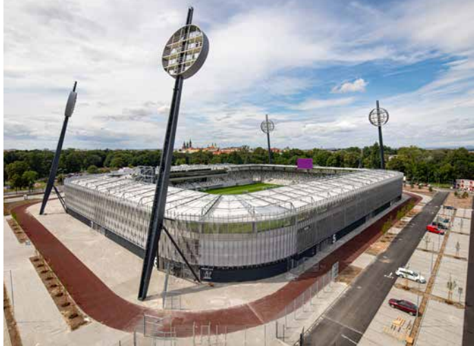
▲ Obr. 2 Osvětlovací stožáry („lízátka“), byly demontovány a po kontrole a repasi umístěny do nových pozic
