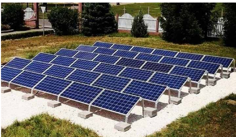
▲ Obr. 6 Příklad instalace FVT panelu na vegetační střeše vodojemu
