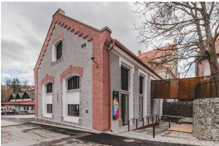
▲ Obr. 12 Objekt návštěvnického centra, nový stav
