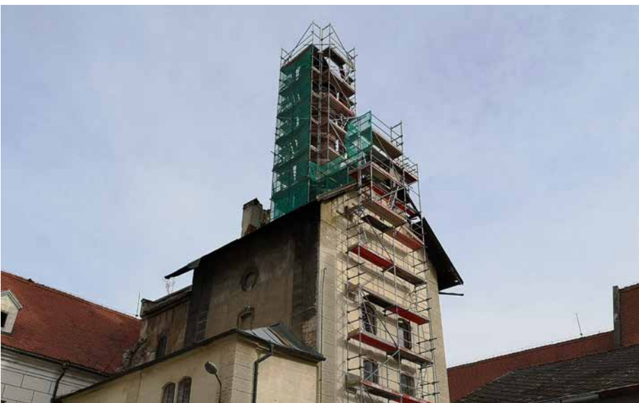
▲ Obr. 10 Práce na rekonstrukci pivovarského komína
