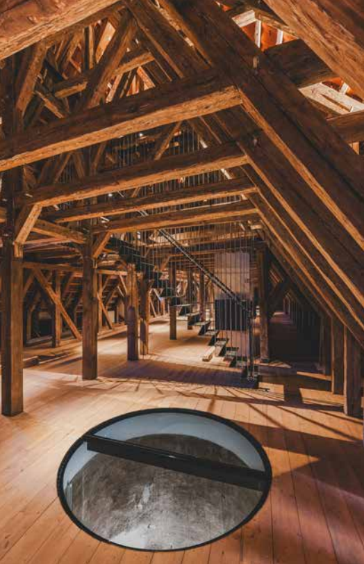
▲ Obr. 19 Unikátní hambalkový krov paláce s prvky z 15. a 16. století, pod nímž byla objevena původní schodišťová věž
