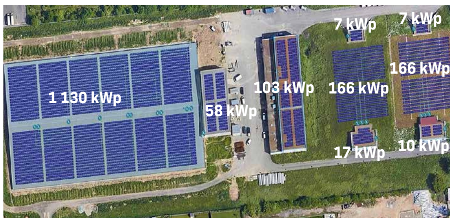
▲ Obr. 7 Dispozice fotovoltaického systému. Čerpací stanice a vodojem v pražské aglomeraci s částí fotovoltaického systému určenou pro vlastní spotřebu a částí pro dodávky do distribuční sítě.
