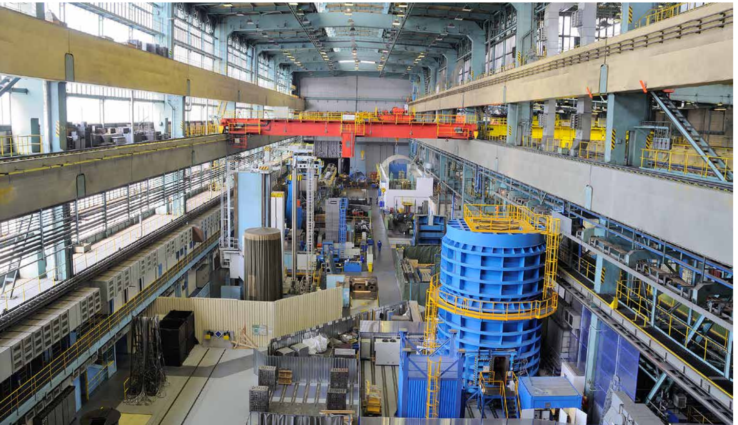
▲ Obr. 1 Pohled na reaktorovou halu
