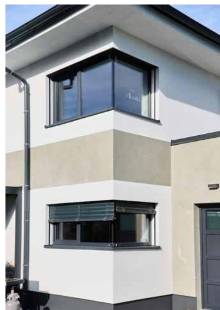
▲ Obr. 5 Dům se zabudovanými izolačními trojisky HELUZ IZOS, rohový detail
