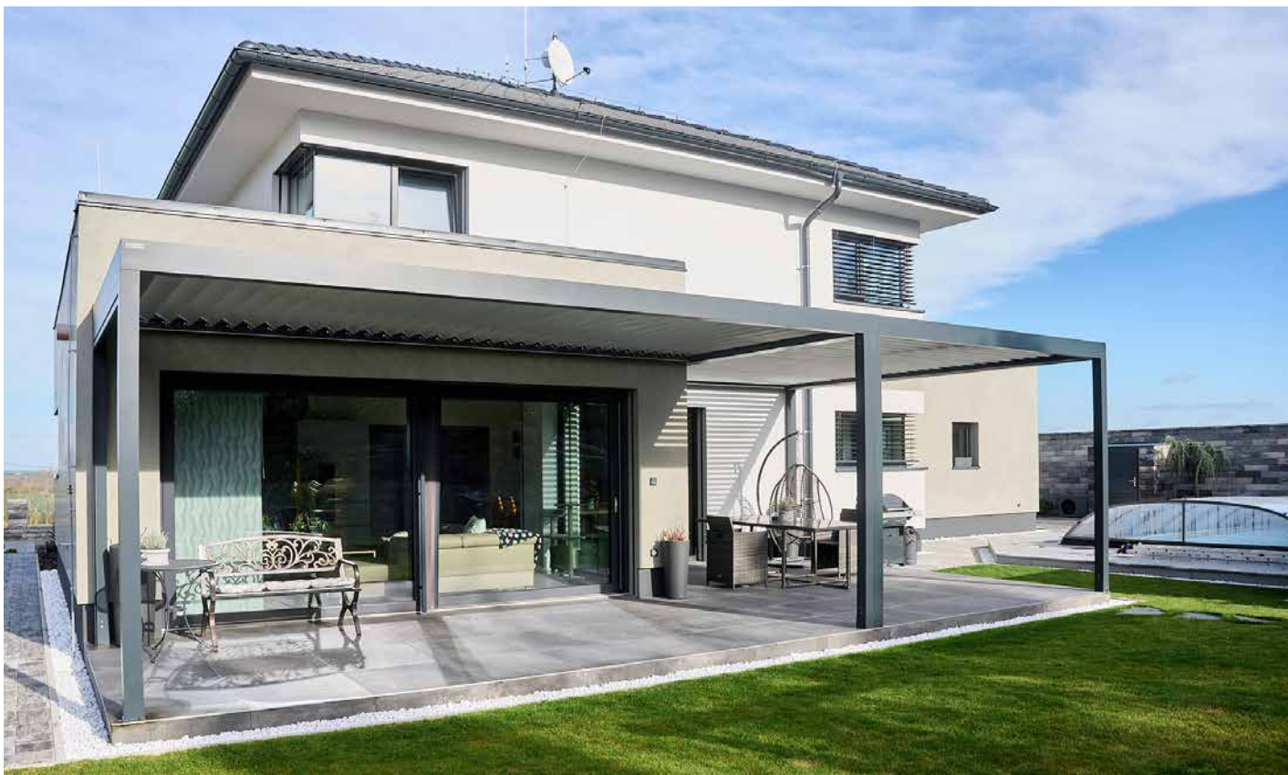
▲ Obr. 1 Dům s HS portálem v šířce 5 m se zabudovanými izolačními trojskly HELUZ IZOS
