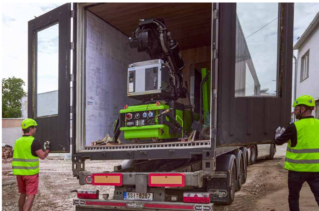
▲ Obr. 3 Přeprava zdícího robota na staveniště
