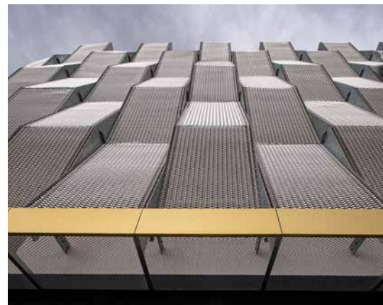
▲ Obr. 4 Zajímavým prvkem je hlavní fasádní plášť zhotovený z prolamovaného tahokovu
