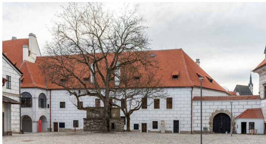
▲ Obr. 3 Objekt renesančního paláce po rekonstrukci
