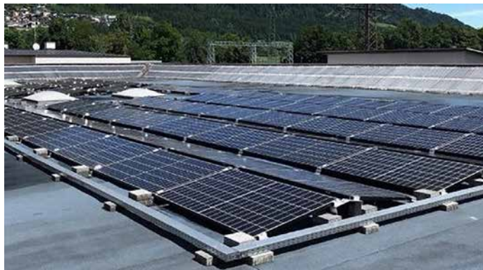
▲ Obr. 5 Příklad přitížení FVT panelu betonovými deskami bez nutnosti zásahu do konstrukce střechy
