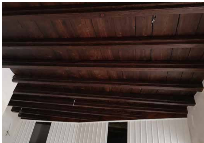
▲ Obr. 16 Původní dřevěný raně renesanční strop ze 16. století nalezený nad dřevěným podbitím po obnově
