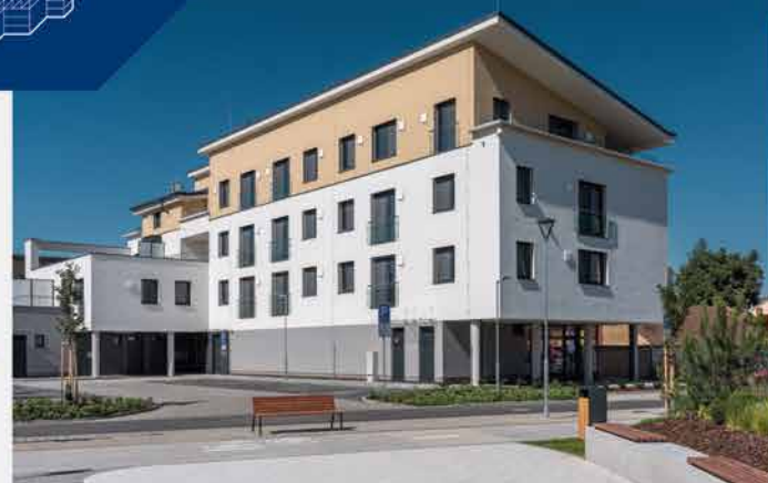
↓ Polyfunkční dům "C" Rezidence Nová tržnice, Věselí nad Moravou
