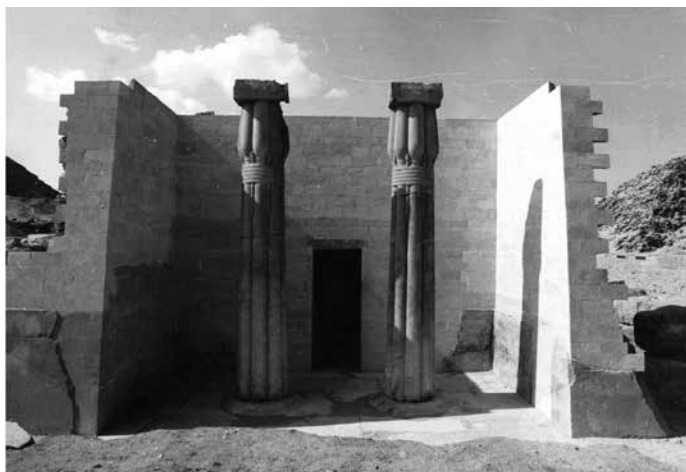
▲ Obr. 9 Jedním ze základních úkolů byla rekonstrukce a obnova piliřového vstupu se sloupy. Tato část byla celkově „dostavěna“.
