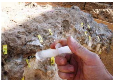
▲ Obr. 19 Části sloupů byly zpevňovány a konzervovány hloubkově, částečně také staticky, s využitím helifixu
