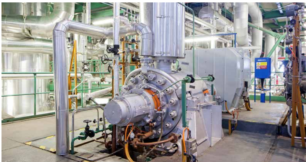
▲ Obr. 3 Napájecí čerpadlo typu KHX v jaderné elektrárně Dukovany
