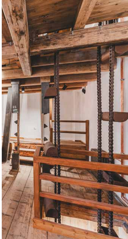
▲ Obr. 20 Nové ocelové korečky výtahů na plad byly opatřeny patinou rzi
