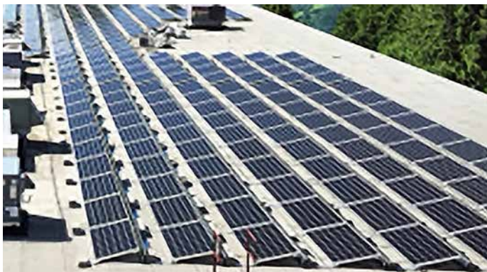
▲ Obr. 5 Příklad přitížení FVT panelu betonovými deskami bez nutnosti zásahu do konstrukce střechy
