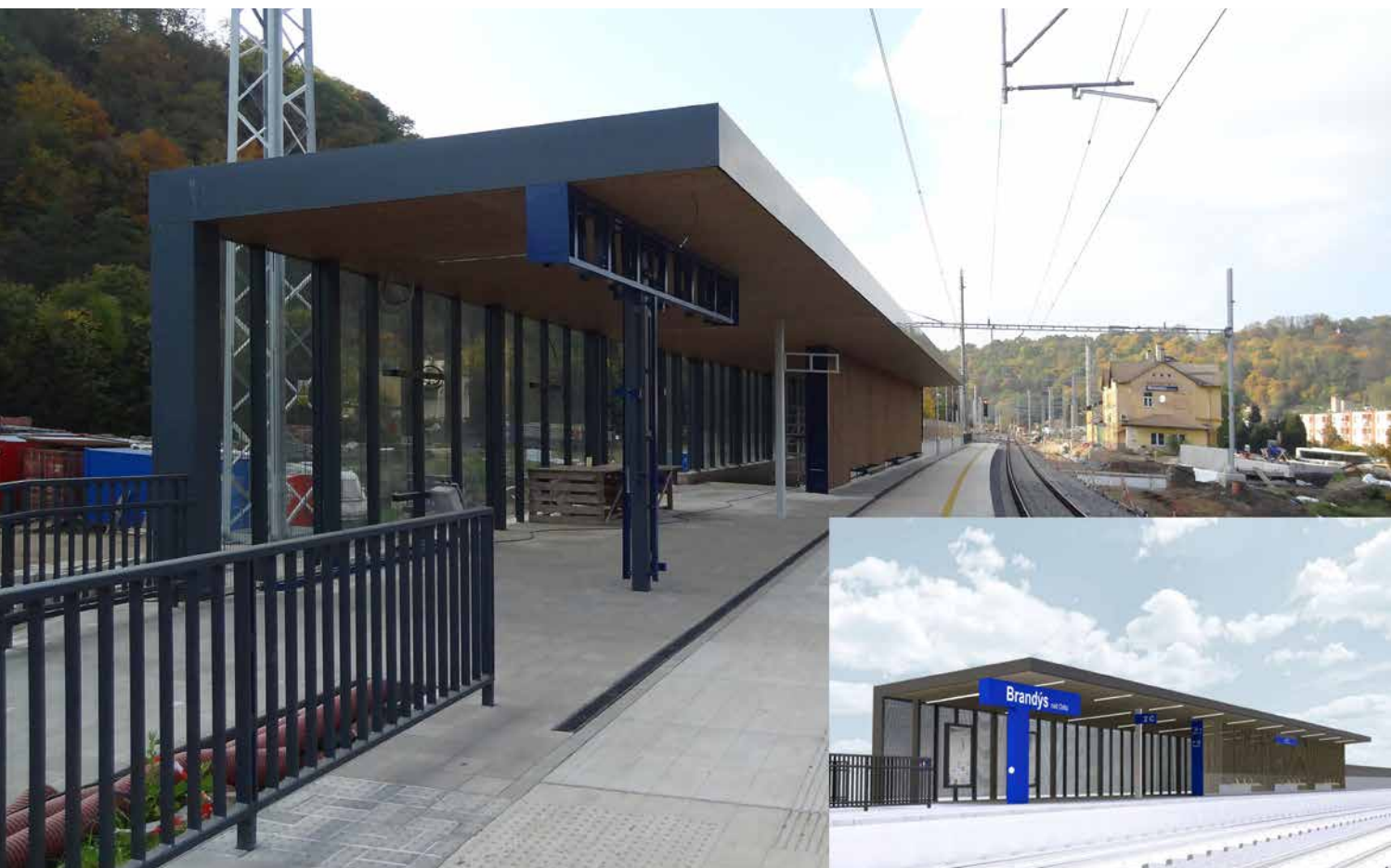
▲ Obr. 1 Rozestavěné zastřešení výstupu z podchodu zastávky Brandýs nad Orlicí. Vzhledem k poloze na hranici městské památkové zóny byly v přípravě projektové dokumentace zpracovány vizualizace (vpravo dole, zdroj: projektová dokumentace stavby Ústí n. O. – Brandýs n. O. – původní stopa, BC, SUDOP PRAHA a.s., 08/2019).
