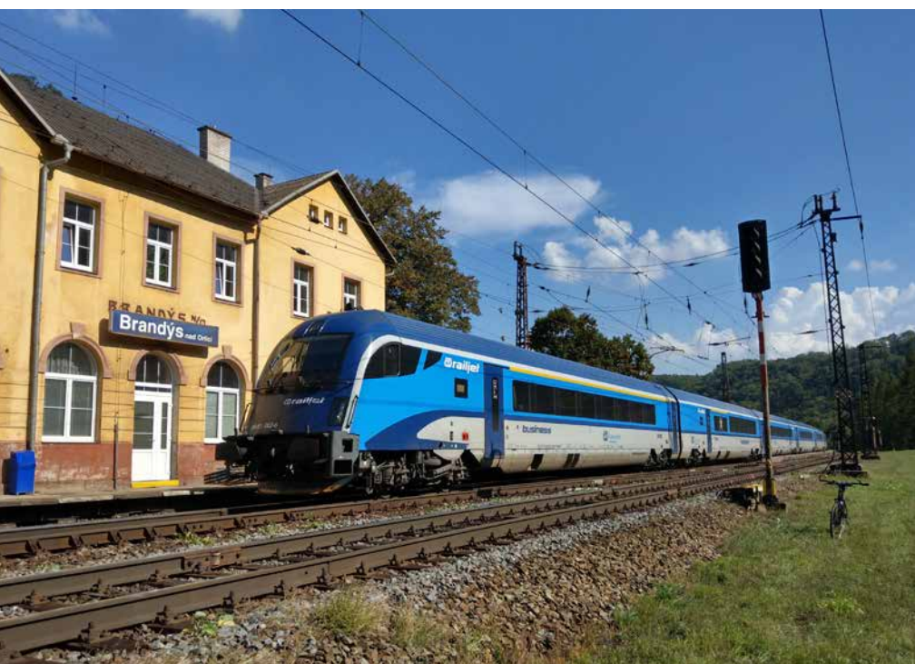
▲ Obr. 9 Setkání staletí – budova je o století starší než projíždějící Railjet, zahrnuta byla do stavby rekonstrukce trati na poslední chvíli; stav před začátkem stavby
