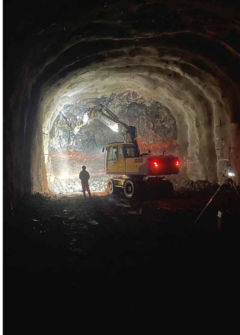
▲ Obr. 9 Mechanické začištění výrubu
