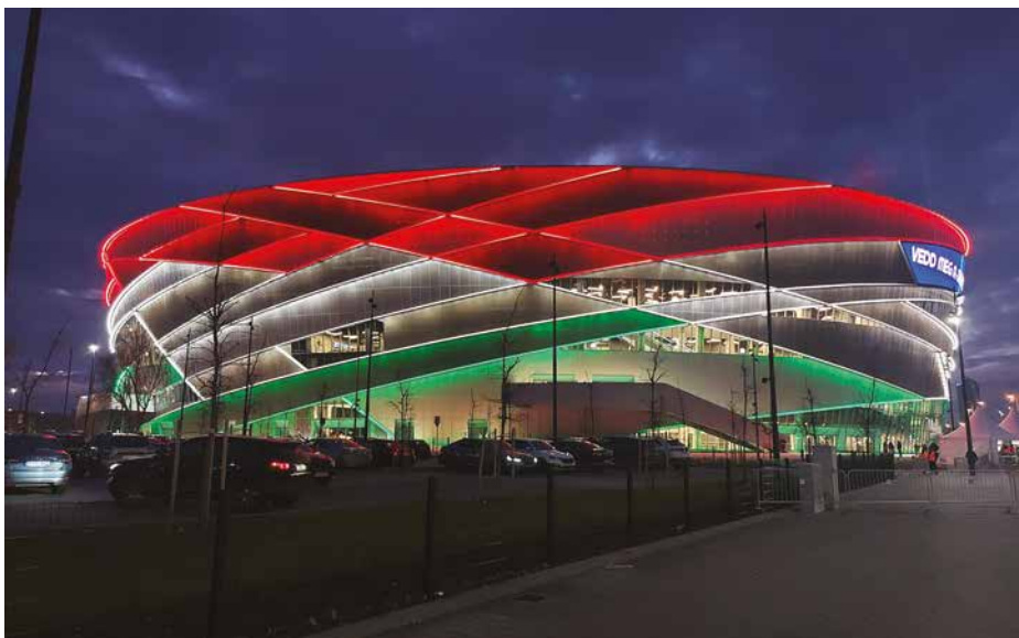
▲ Obr. 1 Multifunkční hala MVM Dome
