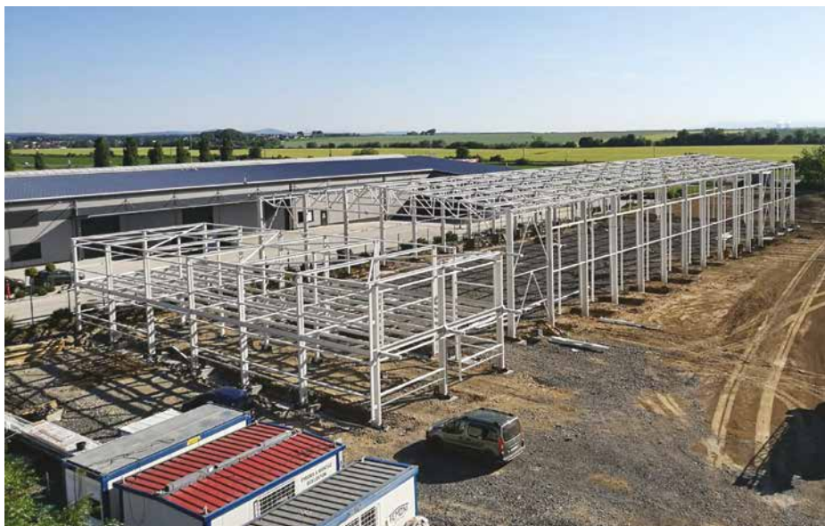
▲ Obr. 2 Ocelový skelet horní stavby
