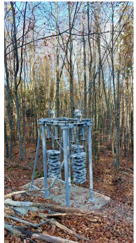
▲ Obr. 17 Nízkofrekvenční tlumiče v sestavě pro tři kotvení lana (foto: Jindřich Syrovátka)
