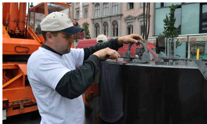
▲ Obr. 11 Fixace montážních ok do kamenného segmentu (foto: Josef Chybík)
