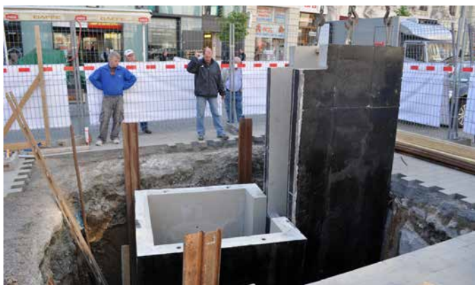
▲ Obr. 10 Osazení prefabrikovaných elementů podzemních stěn (foto: Josef Chybík)
