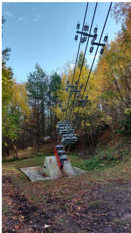
▲ Obr. 12 Vysokofrekvenční pohlcovače typu Stockbridge (foto: Jindřich Syrovátka)
