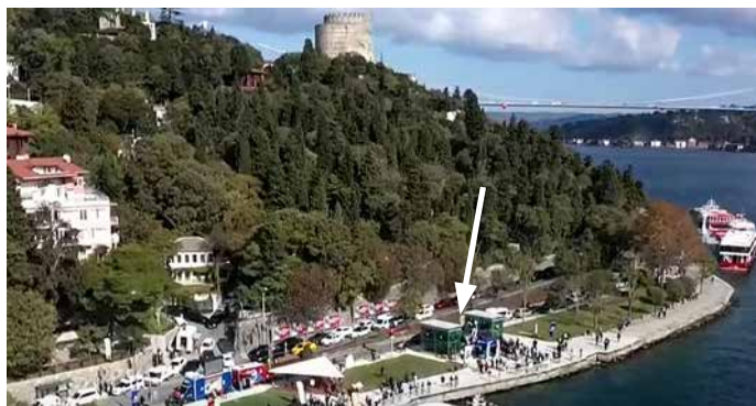
▲ Obr. 3 Dolní stanice podzemní lanovky; z celého podzemního systému nad povrch vystupují jen dvě zelené nástavby výtahů – vyznačeno šipkou (zdroj: archiv stavby)
