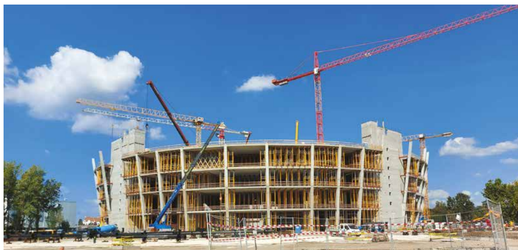
▲ Obr. 4 Projektování probíhalo zároveň se stavebními pracemi s cílem minimalizovat dobu výstavby
