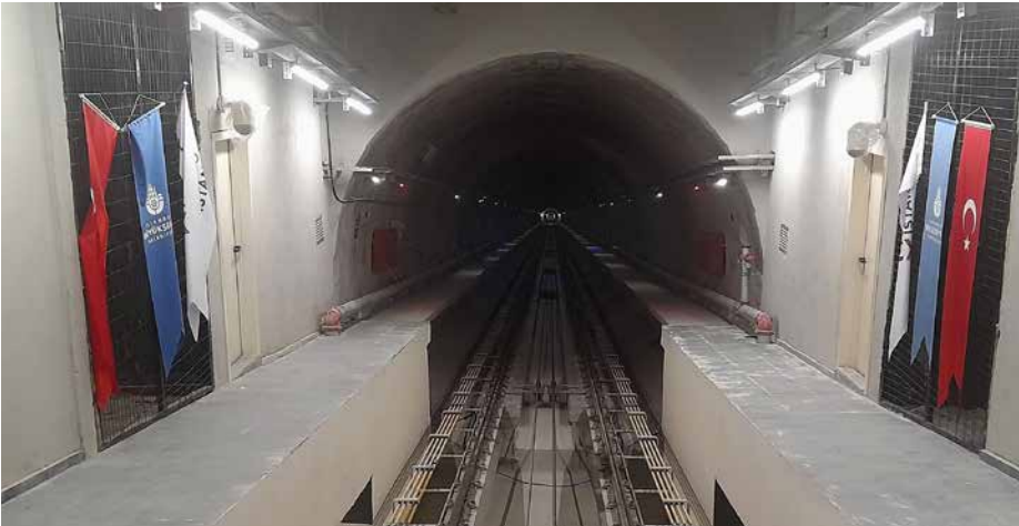
▲ Obr. 12 Přechod staničního profilu tunelu na traťový profil (zdroj: archiv stavby)
