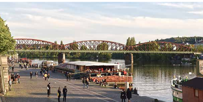
▲ Obr. 1 Celkový pohled na most pod Vyšehradem
