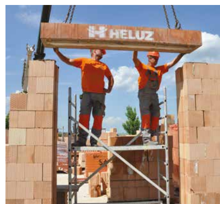
▲ Obr. 3 Montáž překladu do zdiva je rychlá a jednoduchá. Během pár hodin lze namontovat překlady na celý dům
