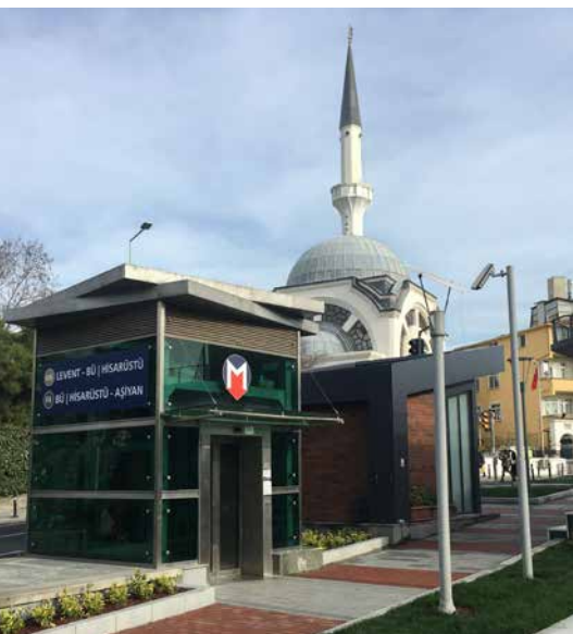
▲ Obr. 9 Horní stanice lanovky (zdroj: archiv stavby)
