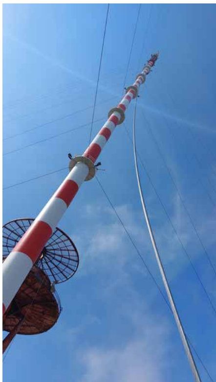
▲ Obr. 11 Zdvih nového lana (foto: Jindřich Syrovátka)
