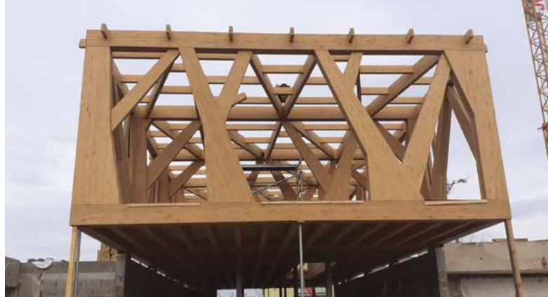
▲ Obr. 4 Pohled na vstupní část nástavby z úrovně terénu
