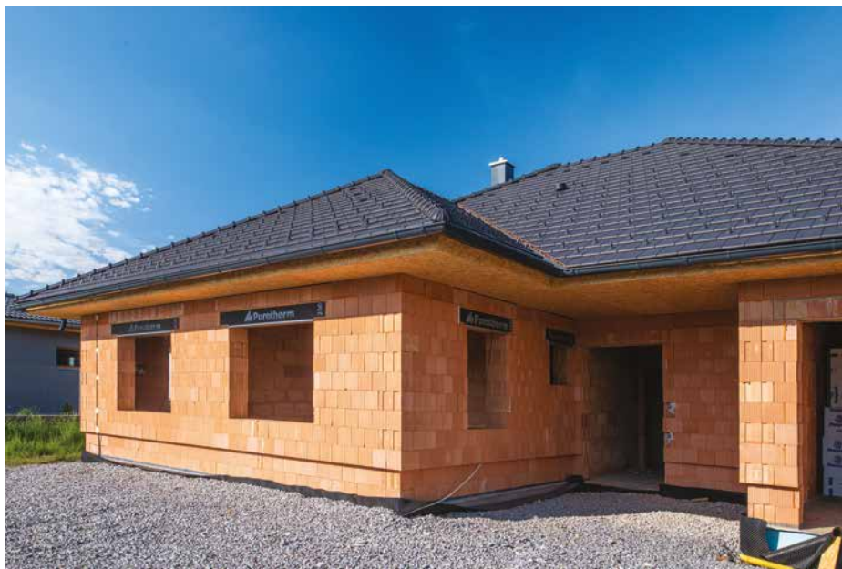
▲ Obr. 1 Hrubá stavba rodinného domu z cihel Porotherm, které jsou plněné minerální vatou T Profi
