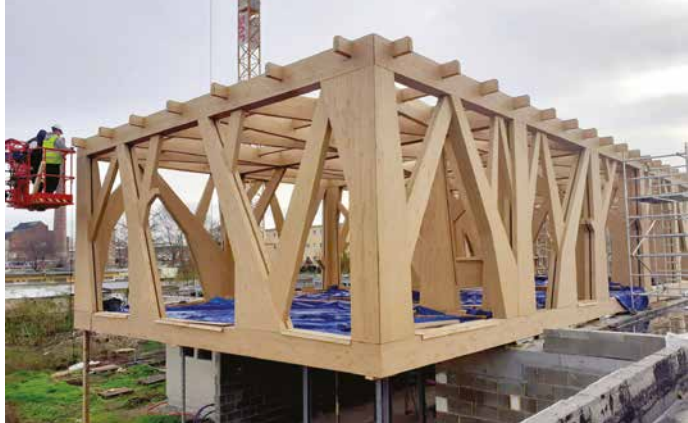
▲ Obr. 3 Převíslá vstupní část nástavby
