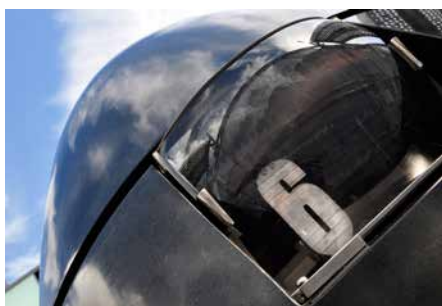
▲ Obr. 4 Pohyblivý kamenný díl hodinového stroje s ciferníkem. Číslicí 6 je uvedena hodina (foto: Zbyněk Hrbata).
