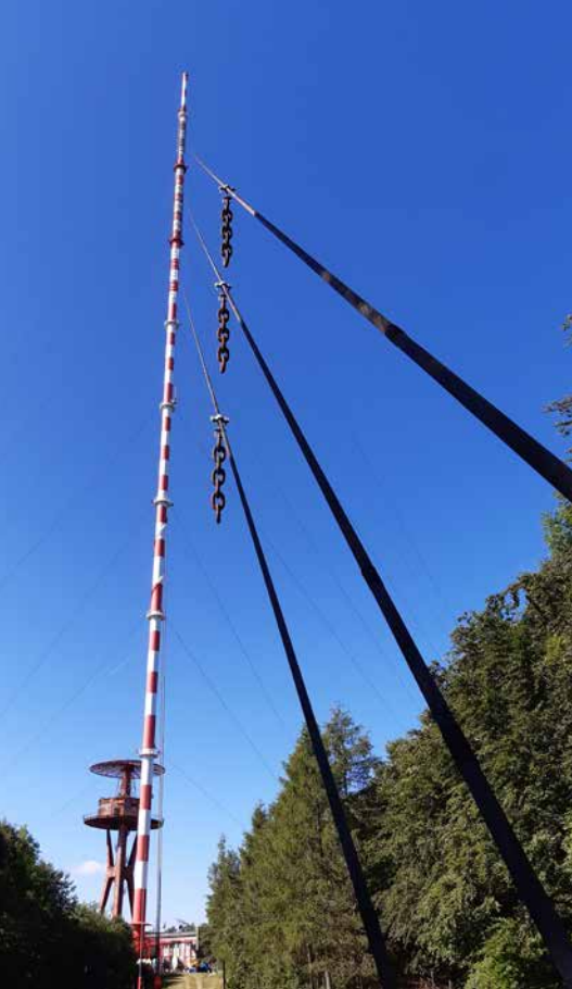
▲ Obr. 3 Původní řetězové pohlcovače kmitů (foto: Jiří Lahodný)
