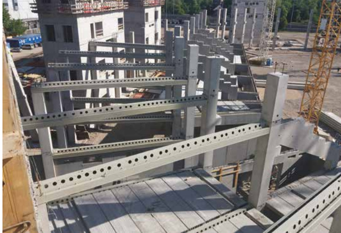
▲ Obr. 2 Na stavbu bylo použito 480 nosníků DELTABEAM® s celkovou délkou více než 4 km
