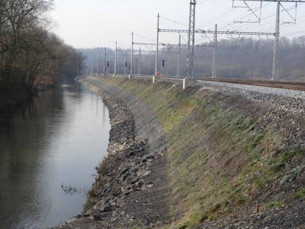
▲ Obr. 8 Opevnění svahu náspu trati tvořícího břeh Tiché Orlice
