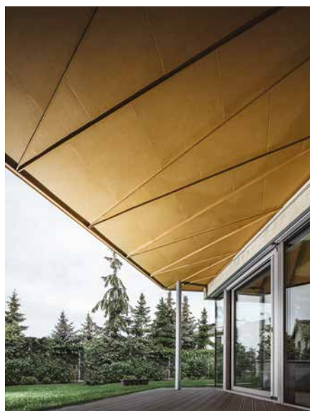
▲ Obr. 3 Podbití, lemování a oplechování ze svitkového plechu Prefalz ve stejné barvě i kvalitě
