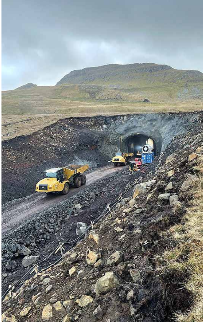
▲ Obr. 8 Dumpery zacouvávající do tunelu před začátkem odtěžby
