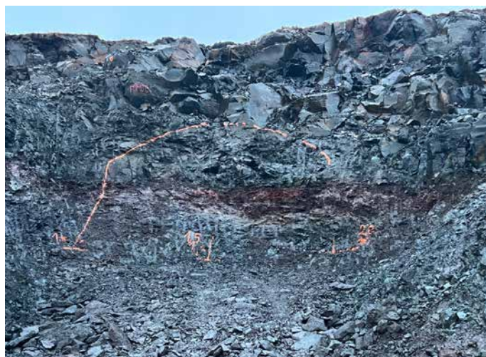
▲ Obr. 3 Pohled na portál před odstřelem
