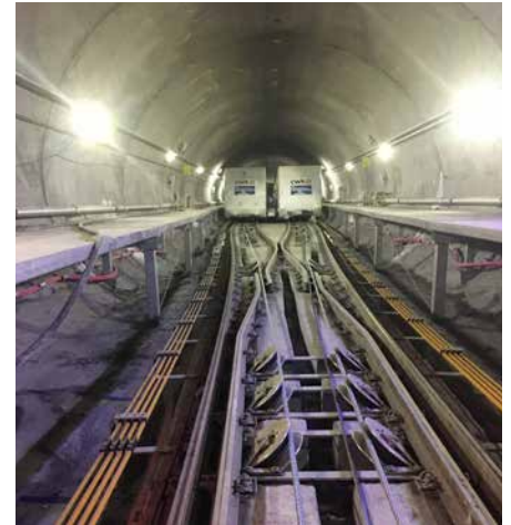
▲ Obr. 13 Výhybna, testy (zdroj: archiv stavby)
