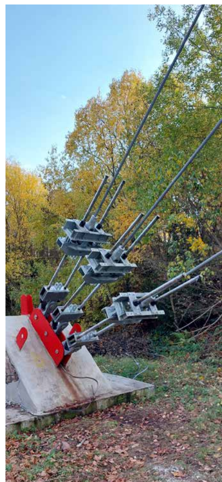
▲ Obr. 6 Nové zakončení lan s montážním příčником pro rektifikaci (foto: Jindřich Syrovátka)
