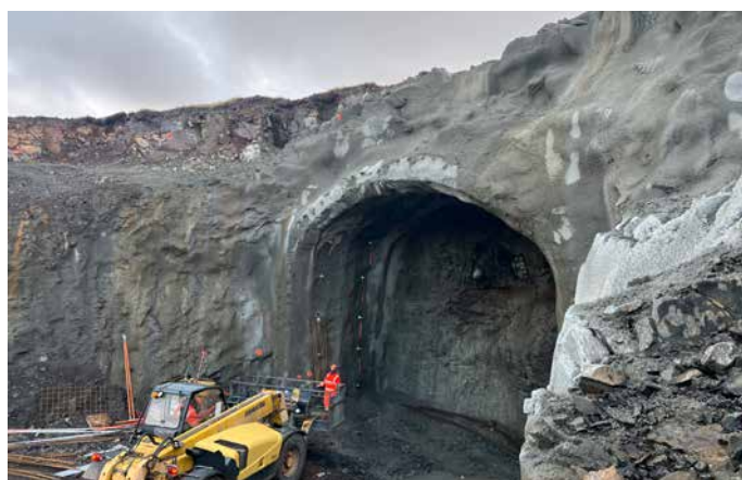
▲ Obr. 5 Nadloží portálu
