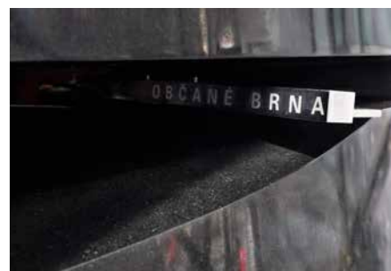
▲ Obr. 6 Spára mezi kamennými segmenty s nerezovou výstrčí (foto: Zbyněk Hrbata)
