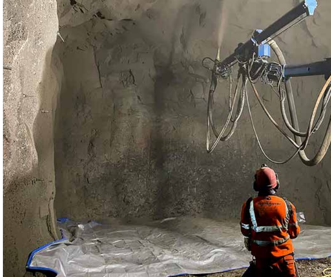
▲ Obr. 11 Proces stříkání betonu na výrub – primární ostění
