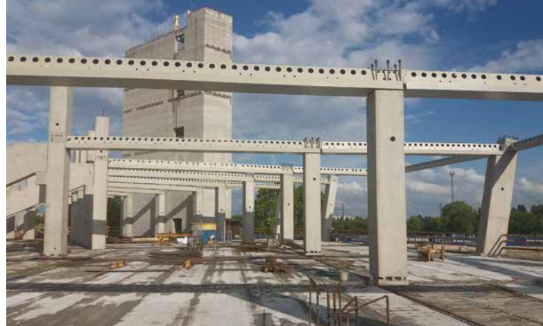
▲ Obr. 3 Nosníky uložené na sloupech byly spojeny pomocí Gerberova spoje
