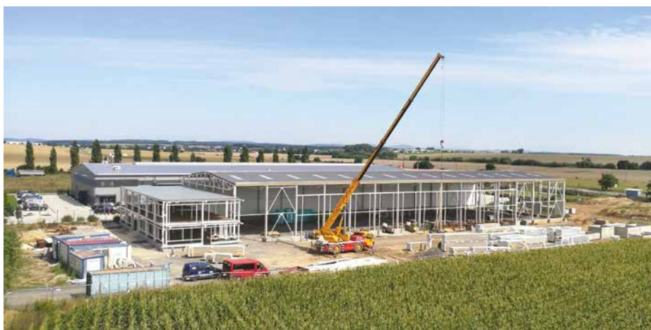
▲ Obr. 3 Realizace opláštění horní stavby
