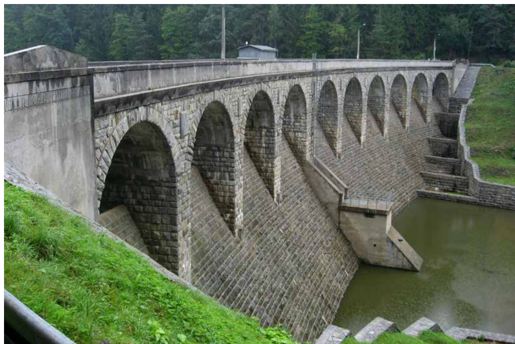
▲ Obr. 7 Vodní nádrž Sedlice, pohled na vzdušní líc hráze (zdroj: Dezidor, 2007, Wikimedia Commons, CC BY-SA 3.0)
