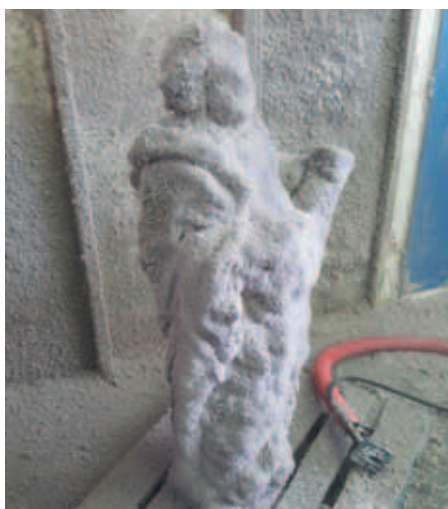
▲ Strojní nástřik odsolovacích obkladů z celulózy je vhodný pro členité povrchy s mnoha detaily. Je výrazně méně pracnou metodou s vynikajícím pokrytím. Rychlost je mnohonásobně rychlejší než při ručním nanášení.
