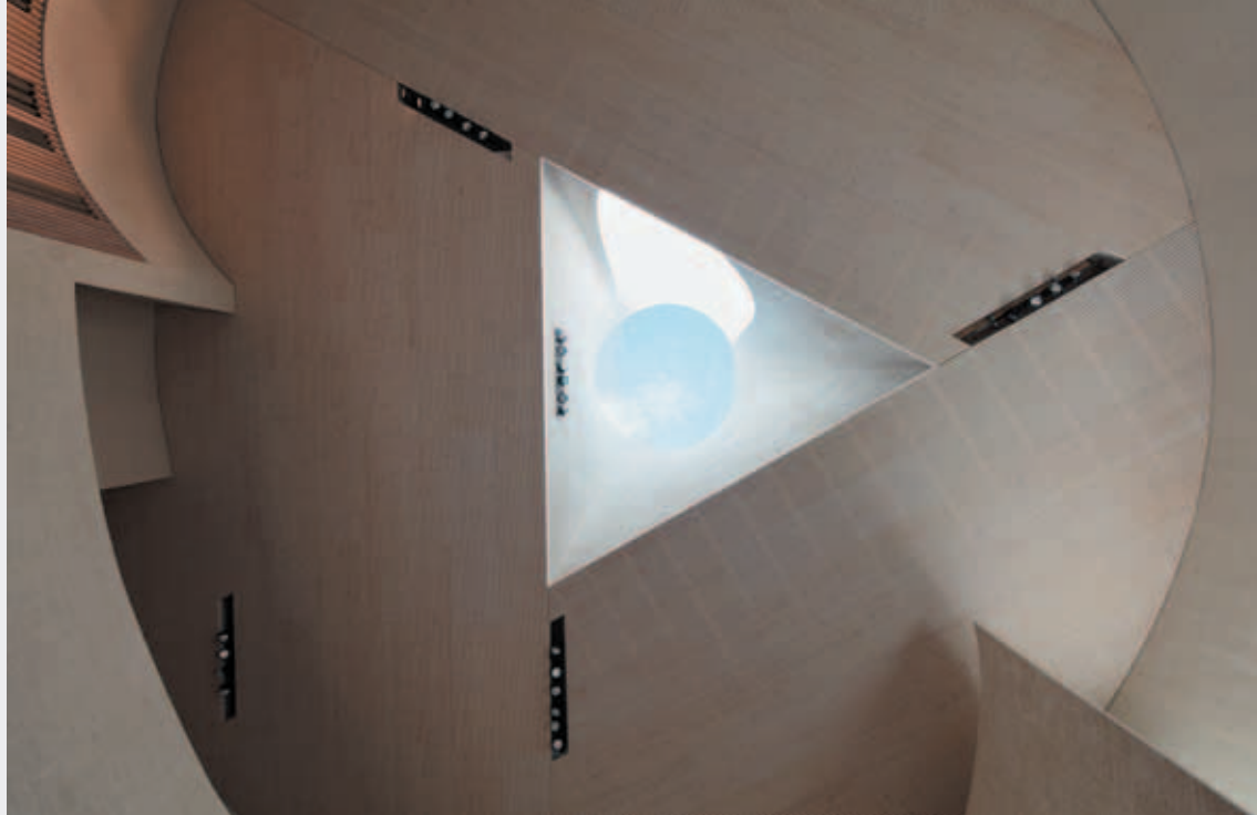
▲ Strop s kruhovým světlíkem přecházejícím do trojúhelníku. Akustický podhled dodržuje orientaci latí směry jeho stran, zároveň jsou v něm umístěny reflektory scénického osvětlení (foto: BoysPlayNice).
