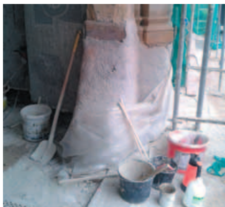
▲ Ruční nanášení odsolovacích obkladů z celulózy je vhodné pro menší plochy. Je to poměrně pracné a vyžaduje to značnou míru pečlivosti v detailech.
