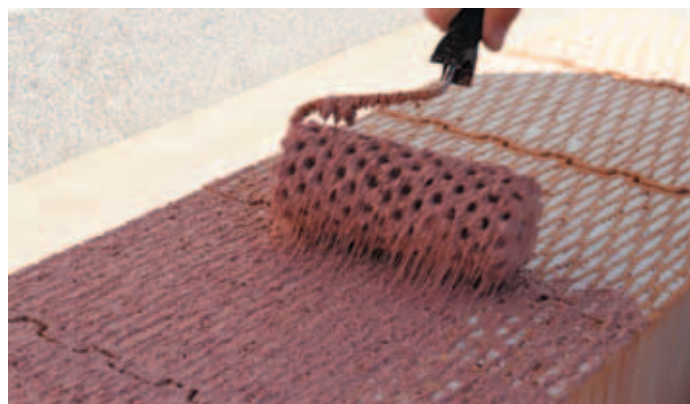
▲ HELUZ SIDI se nanáší rovnoměrně (do kříže), aby pokryl všechna vnitřní i obvodová žebra v ložné ploše cihly.
