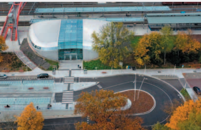
▲ Pohled na výpravní budovu s lávkou
