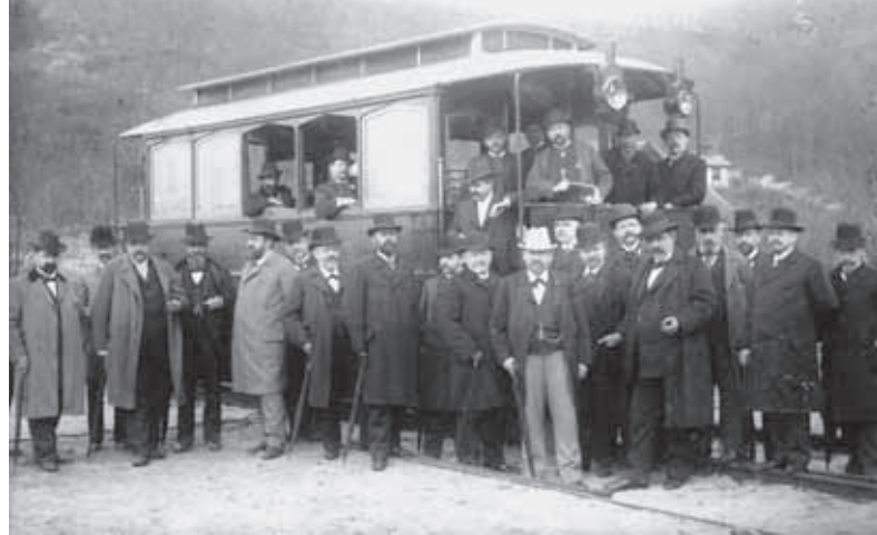
▲ Uplatnit elektrickou energii v dopravě se snažil František Křižík rovněž na železnici. Pro svou pouliční elektrickou dráhu Praha – Libeň – Vysočany zakoupil v roce 1898 ve Vídni dva starší (původně americké) akumulátorové vozy, z nichž jeden upravil pro provoz na železničních kolejích. K pokusům vybral železniční trať Nusle – Modřany – Měchenice. K dobíjení akumulátorů zřídil dvě nabíjecí stanice – v Nuselských topárnách a na Zbraslavi. Dobíjení akumulátorů trvalo 30 min. První jízdu uskutečnil Křižík 6. března 1899. Akumulátorové vozy se při provozu železnice neprosadily, ale pokusy se významně zapsaly do dějin české železniční dopravy [2].
