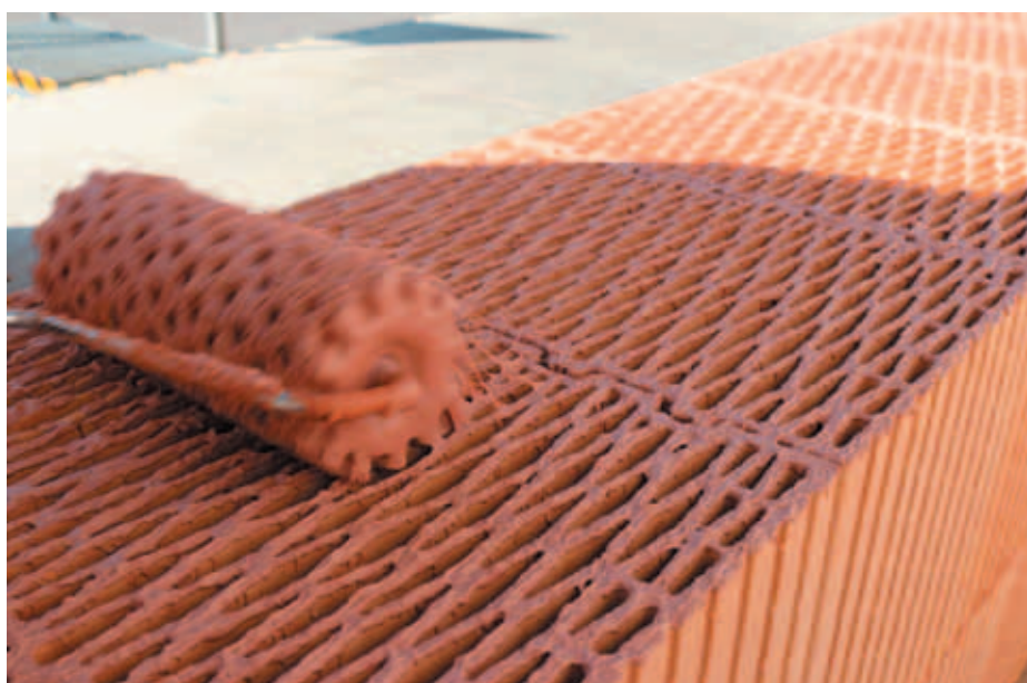
▲ Nanášení malty HELUZ SIDI se provádí systémovým válečkem.
