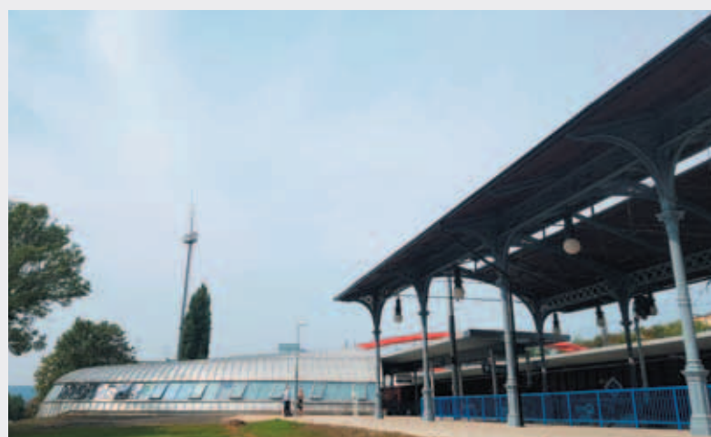
▲ Pohled na výpravní budovu a na historický přístřešek
