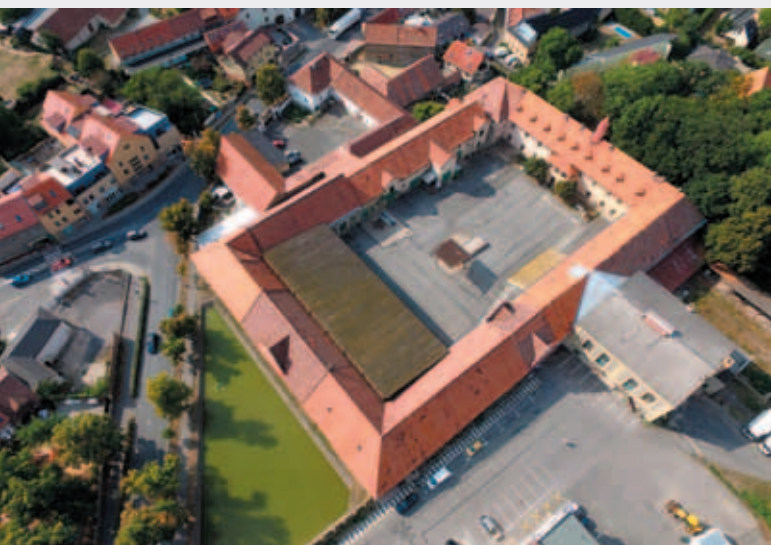
▼ Pohled na areál statku (stávající stav)
